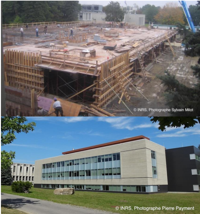
Édifice 18-PRF (Pavillon recherche et formation) en construction en 2006 et en 2013.
