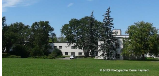
Édifice 12 en rénovation (2006) et aujourd'hui (2013)
